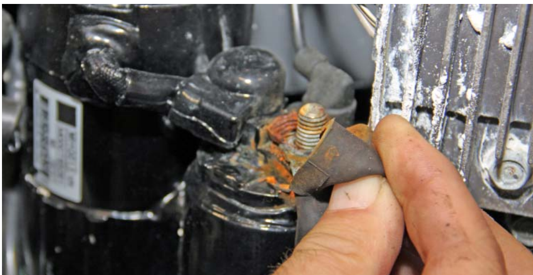
bild 21 Fästmuttern för batterikabelns anslutning vid startmotorn
