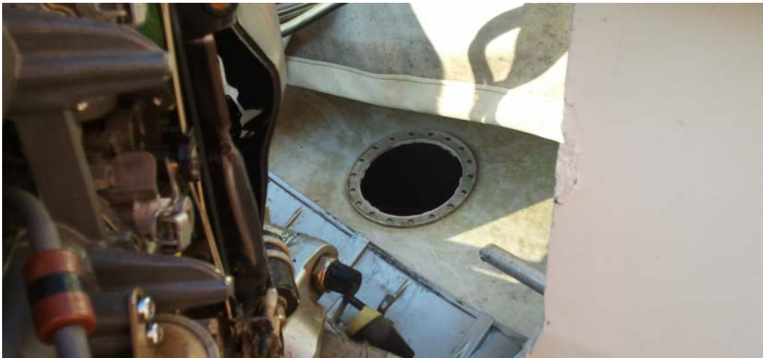
Bild 22 Inspektionsluckan utan lock
