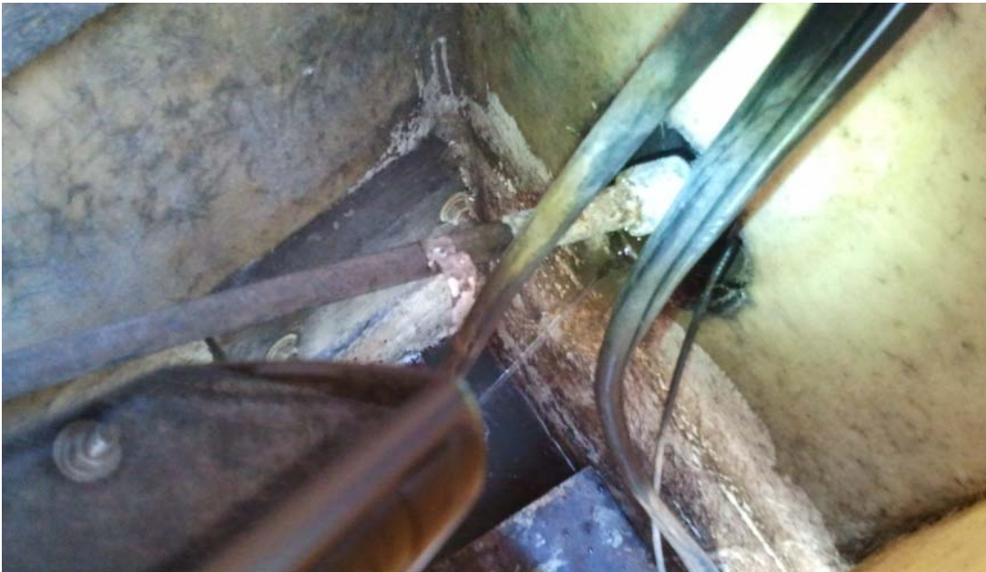
Bild 23 Läckage från motorbrunnen in till batteriutrymmet på styrbordssidan (bild från sjösättningen av Mona III)
