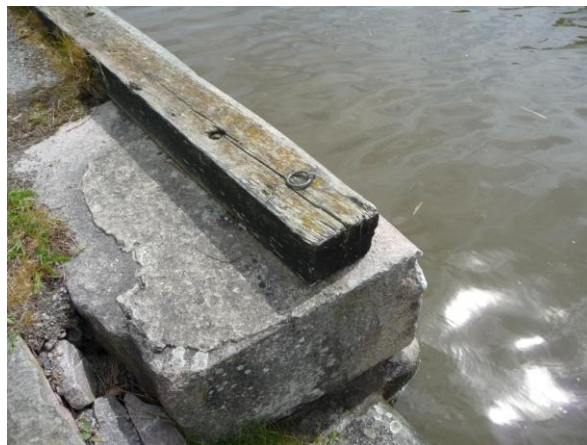
Förtöjningsringar på brofästet
