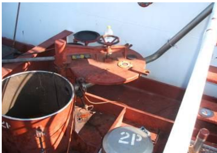
Bild 9 Trunken till 2:an babordstank och den rörböj där kondens kan ansamlas vid styrbords slagsida
