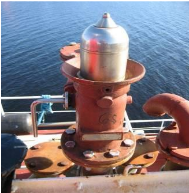
Bild 3 P/V-ventil med checkflit på vänster sida. Vakuumklockan skymtar bakom ventiltoppen.
