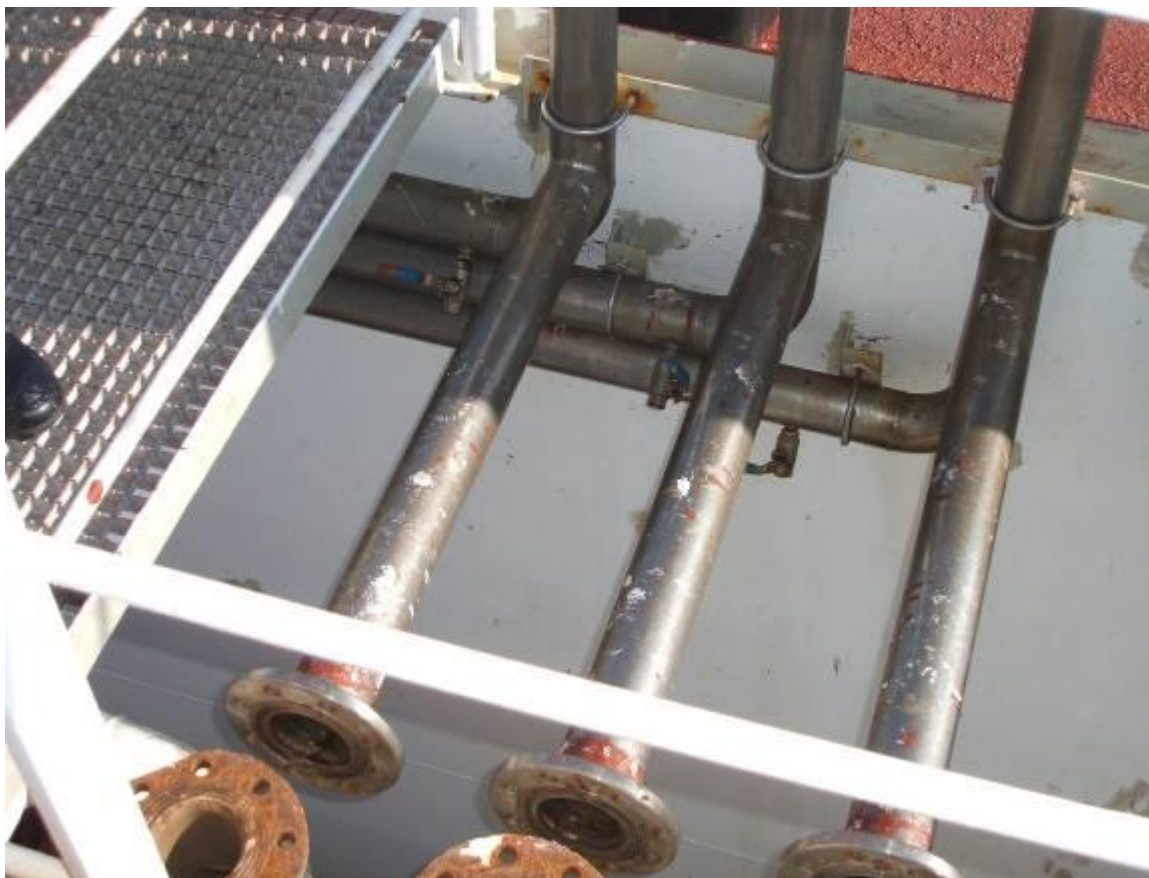
Bild 7 Cross over-rör tillfälligt fränkopplade. De lodräta rören går till P/V-ventilerna. Dränringarna syns under de vågräta rören
