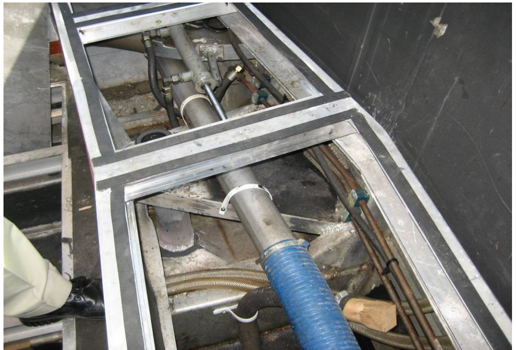
Styrbords hjärtstock innanför det förmodade vattentäta halvskottet
