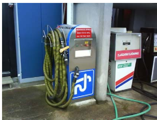
Figur 7. Exempel på bryggmonterad anläggning baserad på membranpumpsteknik
