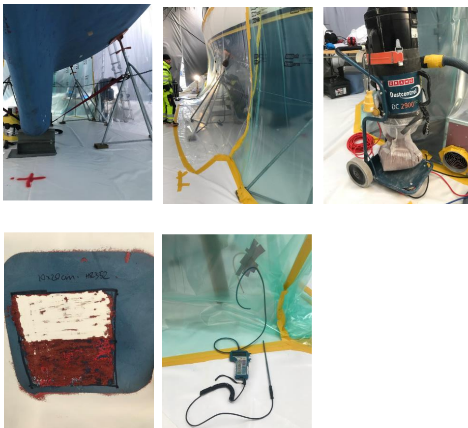
Figur 8. Vy inifrån inneslutningen av en HR352 (överst till vänster), vy utifrån undertrycksatt inneslutning (överst mitten), Industridammsugare/dammfälla som används för undertryck och dammsugning (överst till höger), färgsystem som blåstras från HR 352 (nederst till vänster) samt differentialtrycksmätning under pågående blåstring (nederst till höger).
