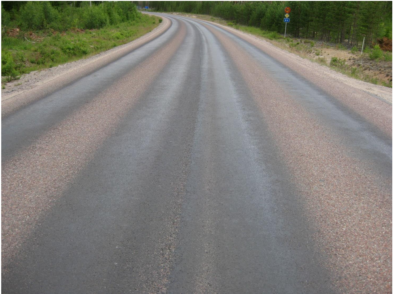
Figur 27 Exempel på en vägyta på gränsen till blödning. Foto: Nils Gunnar Göransson, VTI.
