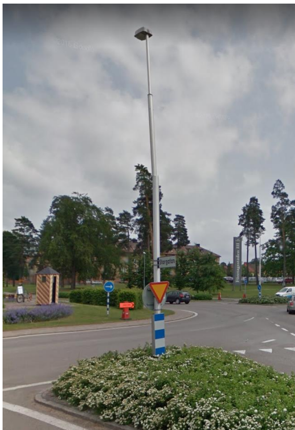
Eftergivlig stolpe med många skyltar som kan påverka dess funktion.
