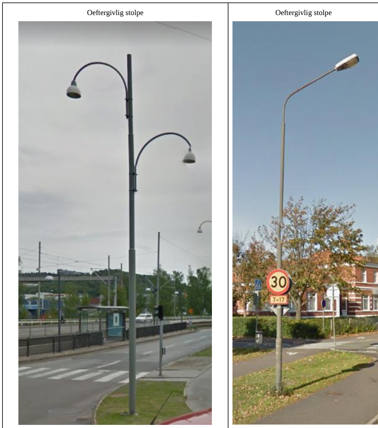
Figur 14. Exempelbilder från Google maps på eftergivliga och oeftergivliga belysningsstolpar.
