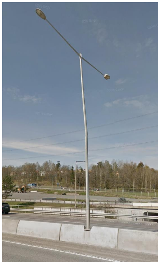
Eftergivlig stolpe på vägräcke, zonen för uppfångning hamnar på fel ställe.
