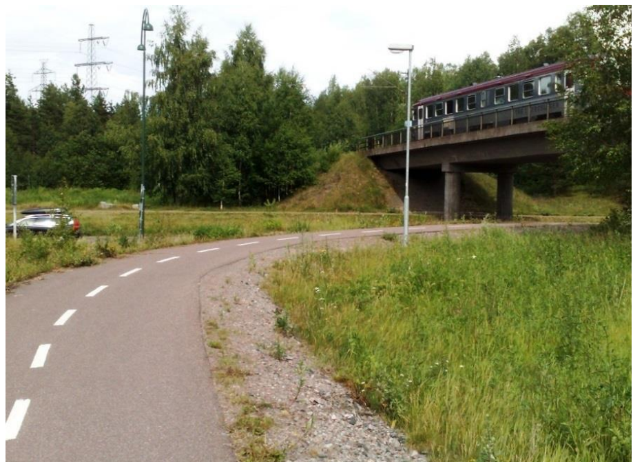
Figur 29 Trafikfarligt feldoserad kurva på GC-väg i Mellsta, Borlänge. Foto: J. Granlund
