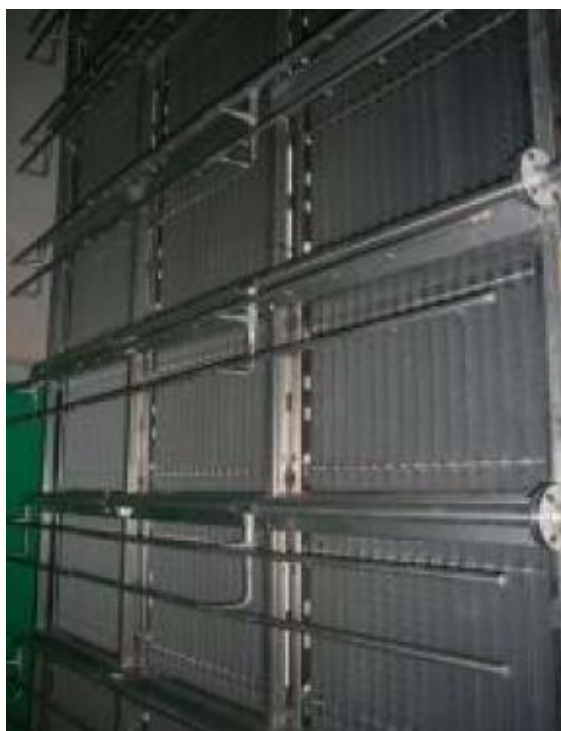
Figur 16. Elektrostatfilter för partikelrening (Lai, 2016).
