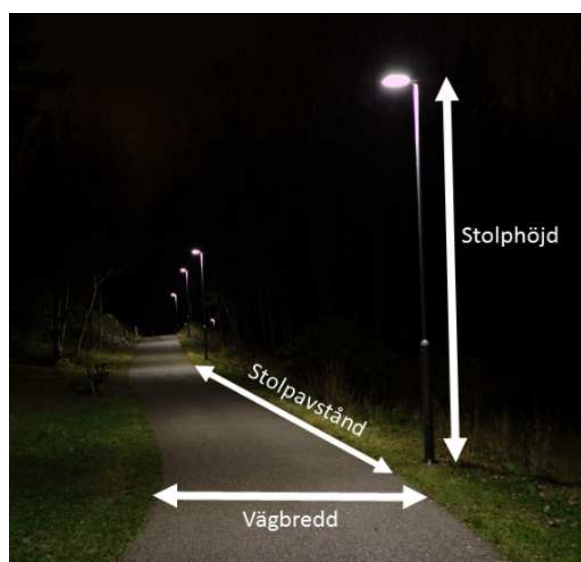
Figur 3. Bild som visar LED-belysning på gång- och cykelväg i naturmiljöområde, samt stolphöjd, stolpavstånd och vägbredd.
