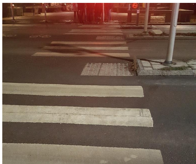
Figur 14. Nybyggt övergångsställe utan upphöjda mittrefuger i Linköping. Bild: A. Arvidsson
