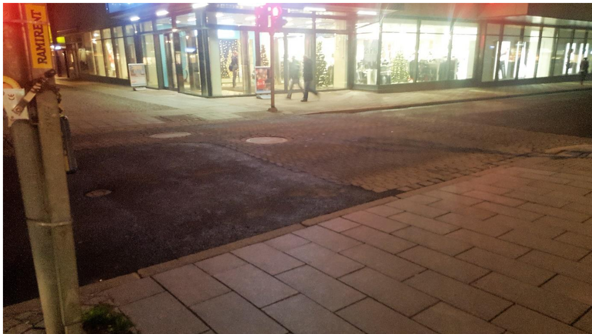
Figur 13. Nybyggt övergångsställe med hela bredden i nollnivå i Linköping. Bild: A. Arvidsson
