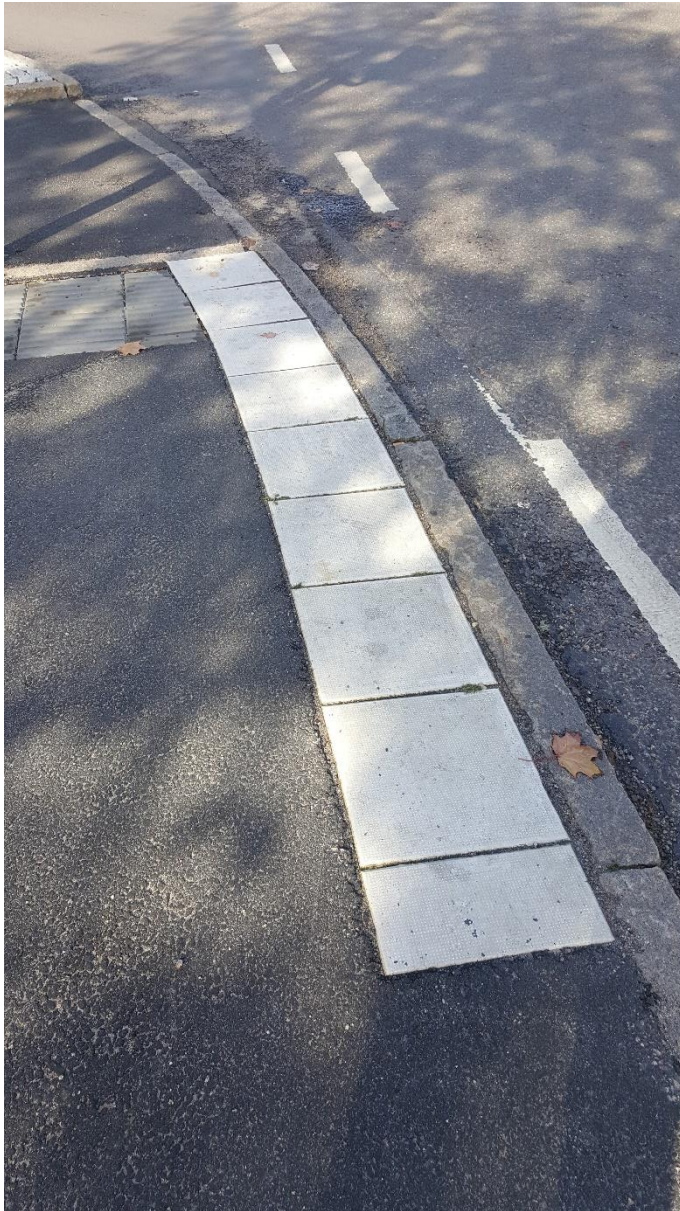
Figur 15. Nybyggt övergångsställe med förtydligande av trottoarkanten i Alingsås. Bild: A. Arvidsson
