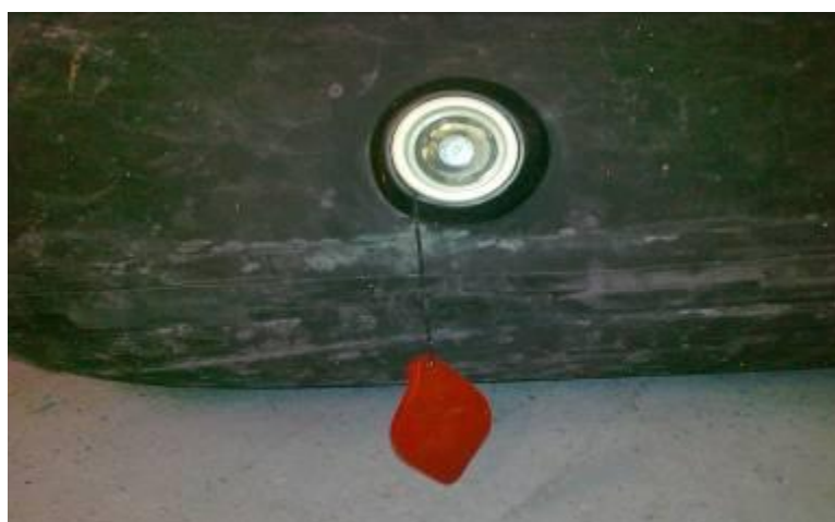
Bild 4. Överströmningsventilen med sitt lock
