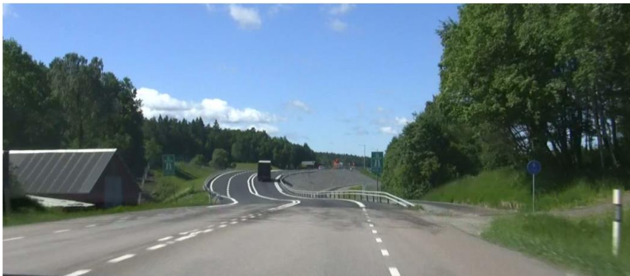
Figur 18 Samma plats i motsatt riktning, här ser man även gångpassagen i direkt anslutning till motorvägen som tillkommit inför trafikens öppnande och som inte fanns på några ritningar.
