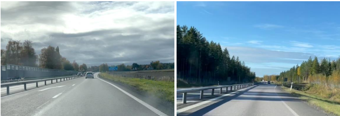
Figur 12 Linjeföringen vid hopvävning och utökning av körfält där genomgående trafik i K1 får en sidorörelse.
