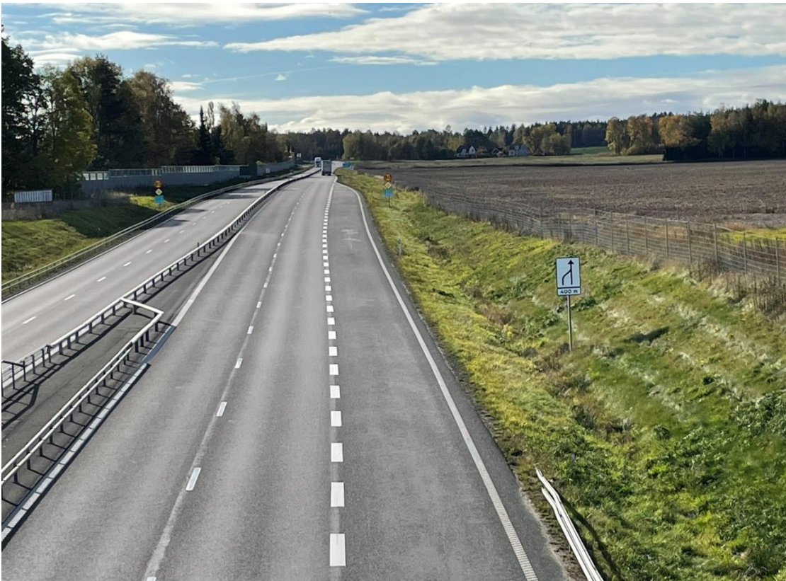
Figur 7 Påfarten i riktning söderut i trafikplats Hova ansluter precis innan två körfält väver ihop till ett. Strax söder om hopvävningen tillkommer ett vänstersvängsfält varför det blir som en "midja" där trafik i K1 får två sidoförskjutningar efter varandra, först till vänster och sedan till höger.
