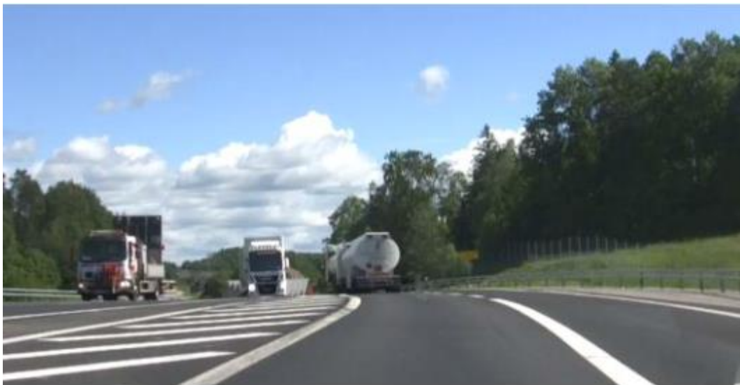
Figur 17 Dålig sikt vid provisorisk anslutning mellan ny och befintlig vägsträcka
