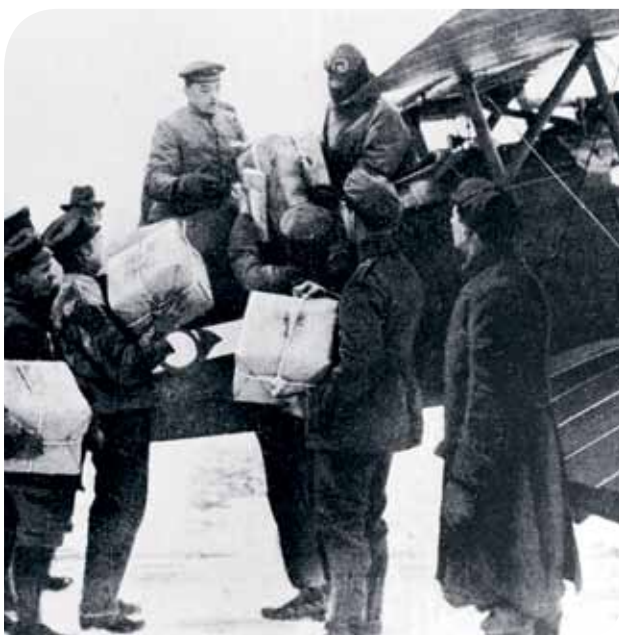
Den första europeiska flygposten på sträckan Berlin–Weimar, 1919. Foto: Luftbahnsa.
